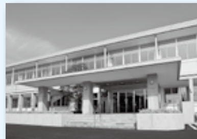
須賀川信用金庫本部
